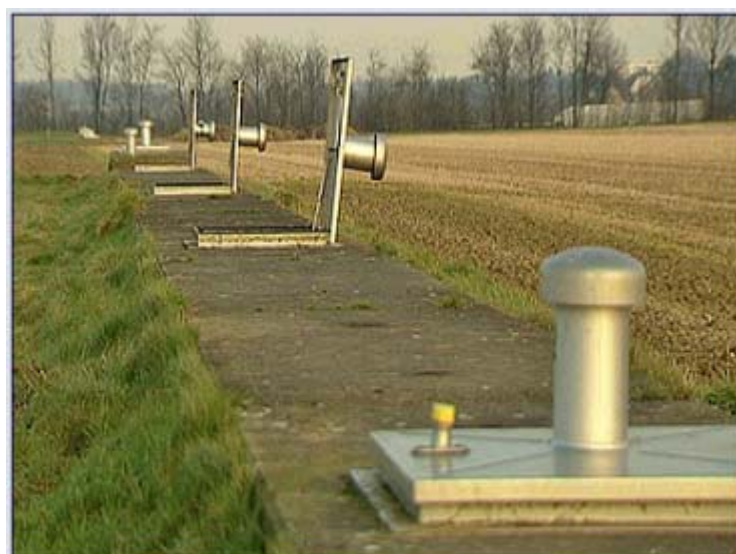
Sickergruben verhindern das weitere Absinken des Grundwasserspiegels
