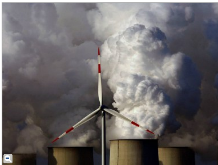
Eine Windkraftanlage vor den Schloten eines Braunkohlekraftwerks. (Bild: ddp)
