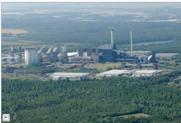
Auf einer Freifläche des Goldenbergwerks in Hürth-Knapsack soll das neue Kraftwerk mit der sauberen Technologie entstehen. (Bild: Beissel)
