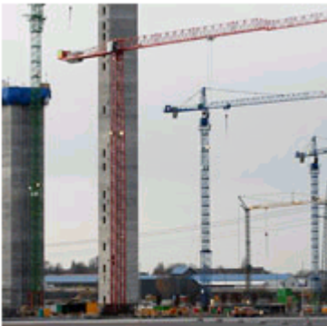
Kraftwerk im Bau: Gericht erklärt Bebauungsplan für Eon-Kraftwerk in Datteln für nichtig
