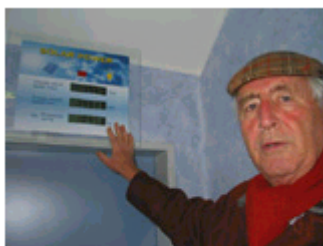
Stenzel zeigt die Photovoltaikanlage
