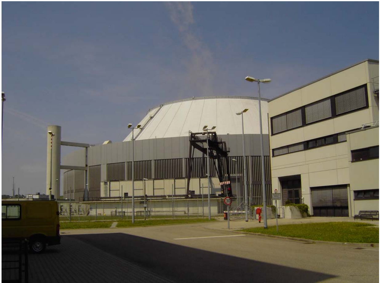
Kühlturm des Kraftwerks in Neckarwestheim (08.06.2007)
