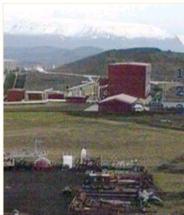
In Island gehören geothermische Kraftwerke zum Alltag
