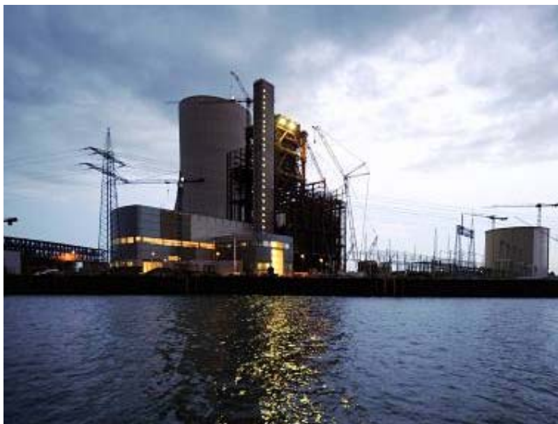
Gefährdetes Milliardenprojekt: Das Kraftwerk Datteln. (Bild: ddp)
