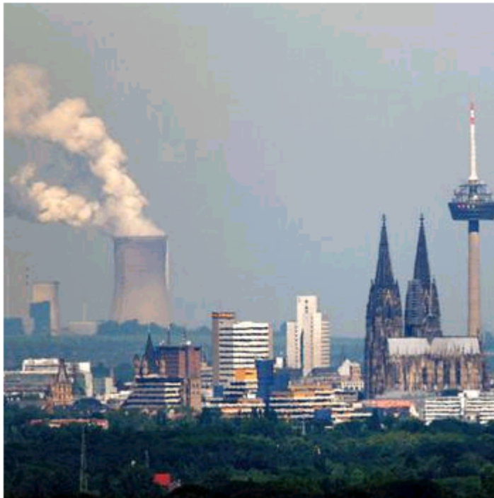
RWE-Kraftwerk Niederaußern nahe Köln. Quelle: dpa
