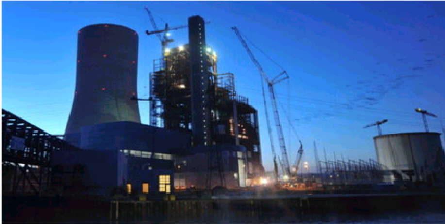
Steht weiter ohne Beschluss in der Gegend: Das im Bau befindliche Kraftwerk bei Datteln.
